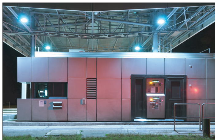
Éclairage de couloir de péage sur l'A62
