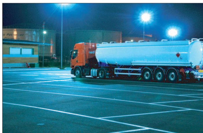
Éclairage du parking d'accueil
